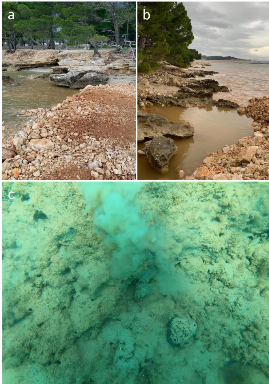
Slika 3. Primjer neposrednog utjecaja nasipavanje plaže Cvitačka/Biloševac u Makarskoj: a) nasipani stjenoviti materijal s visokim udjelom zemlje u supra- i mediolitoralu, b) замуćenje stupca morske vode i c) sloj finog sedimenta koji prekriva infralitoralnu zajednicu čvrstog dna. Preuzeto iz: Birčić i Rajčić (2021).
