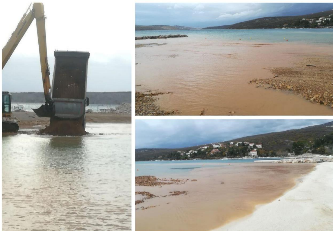
Slika 10. Nasipani materijal s primjesama zemlje korišten pri formiranju plaže Grabrova u Jadranovu, Primorsko-Goranska županija (fotografije anonimnih mještana, ustupljene ljubaznošću M. Arko-Pijevac).
